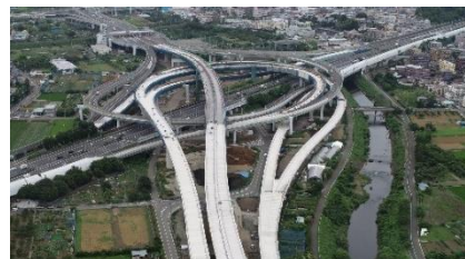
1 横浜青葉IC・JCT(仮称) (上部工架設完了)
