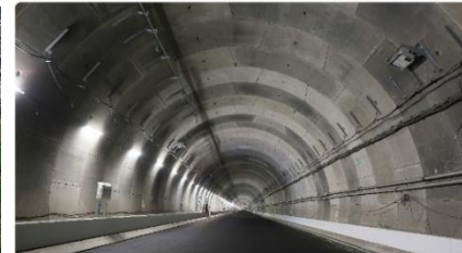
2 トンネル部 (舗装工等を実施中)
