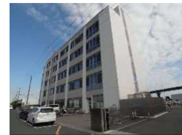
防災拠点の事例(羽田補修基地)
