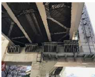
橋梁の耐震補強例 (左: 支承取換え、右: 段差防止装置)
