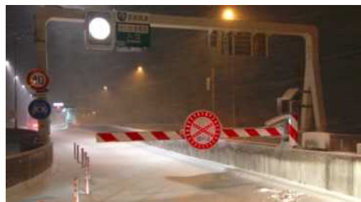
手動遮断機の遠隔化
