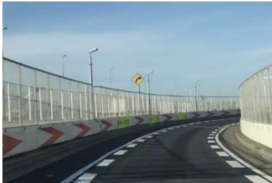
舗装打換え・減速レーンマーク
