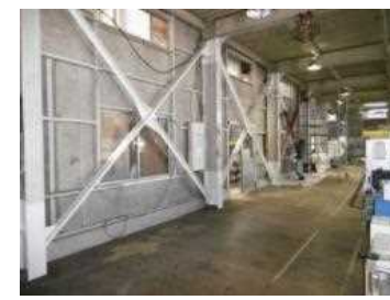
ブレース増設による補強
