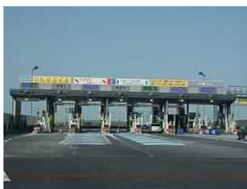
耐震補強を要する料金所の事例 (八潮本線料金所)
