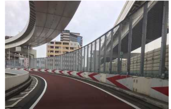
注意喚起カラー舗装、フェンス設置(二輪車安全対策)
