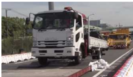
地震時の道路啓開作業(訓練)
