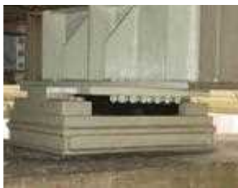
橋梁の耐震補強例 (左: 支承取換え、右: 段差防止装置)
