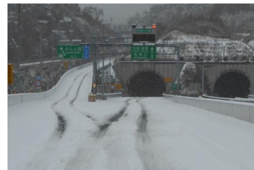
積雪による通行止の状況（北神戸線）
