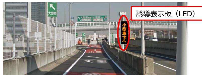
LED誘導表示板
