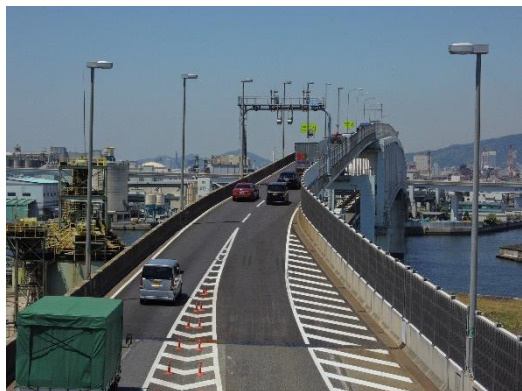
5号湾岸線下り住吉浜出口を2車線化
