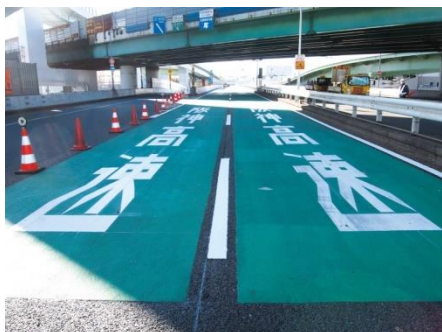
誤進入防止を目的としたカラー舗装
