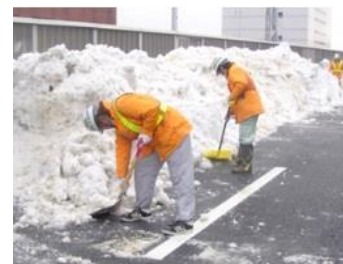
路肩を人力除雪
