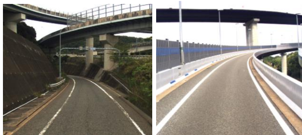
交通流監視カメラから死角となっている出入口
