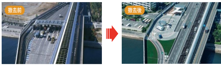
本線料金所撤去跡地をPA整備
