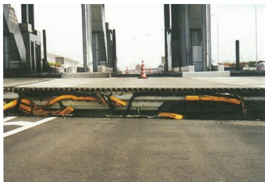
阪神淡路大震災の被害 (段差発生状況)
