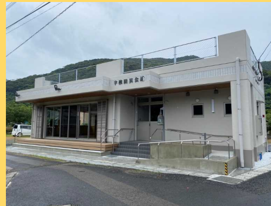
宇検集落防災避難施設避難施設整備(宇検村)
