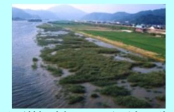
河道掘削による湿地再生 (円山川、兵庫県豊岡市)
