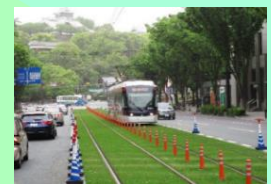
軌道敷緑化の整備 (熊本県熊本市)
