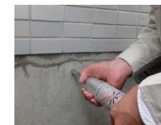
リバウンドハンマーを用いた コンクリートの圧縮強度の測定
