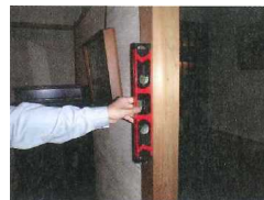
水平器による 柱の傾きの計測
