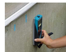
基礎配筋の調査
