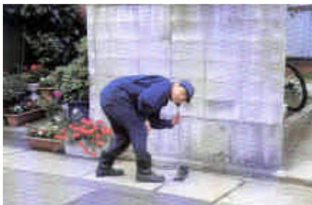
聴音棒による漏水調査
