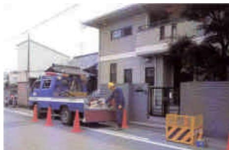
漏水探知装置による漏水調査
