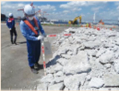
港湾工事で使用される船渠の再利用
