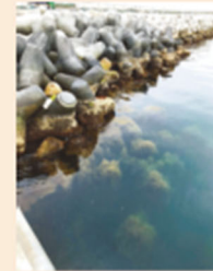
防波堤に形成される備場
