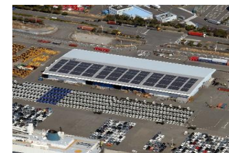
横浜港における太陽光発電設備
