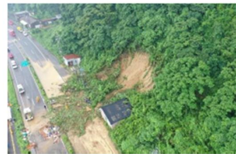
国道7号の土砂流入(秋田県秋田市)
