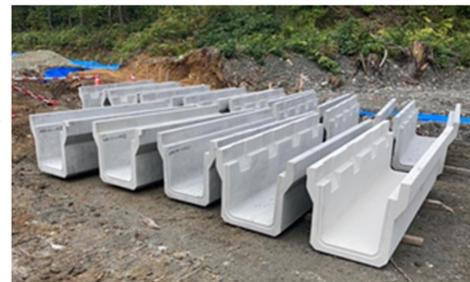
グリーンインベーション基金を活用したCO2固定化コンクリート試行事例(秋田県東成瀬村)
