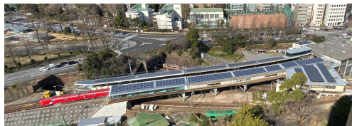
東京メトロ提供 丸ノ内線四ツ谷駅
