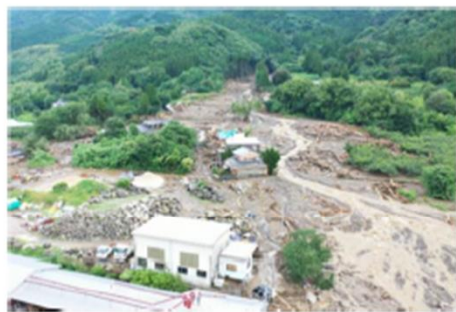
土石流による被害 (福岡県久留米市田主丸町)
