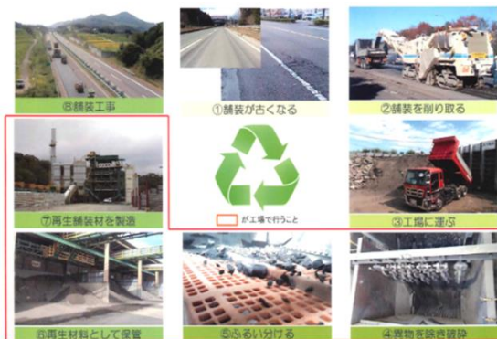
アスファルト舗装のリサイクル
