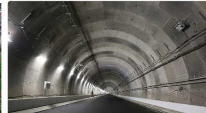
2 トンネル部 (舗装工等を実施中)
