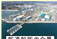
新造船所の全景
