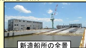
新造船所の全景
