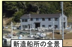
新造船所の全景
