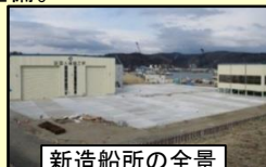
新造船所の全景
