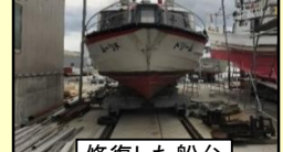
修復した船台
