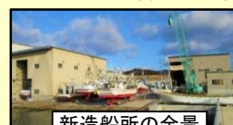
新造船所の全景
