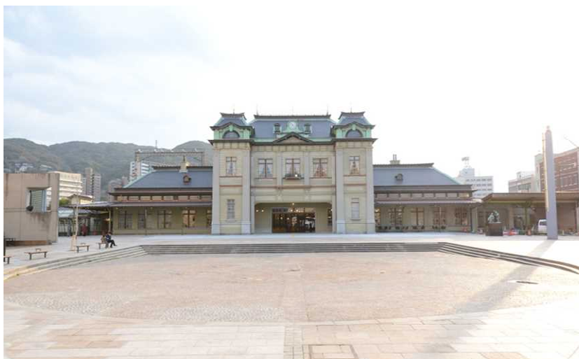
復原工事完了後全景
