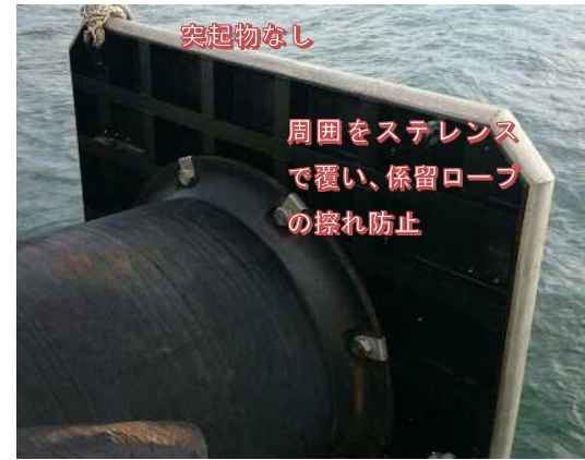
写真10：係留ロープが絡みにくい対策
