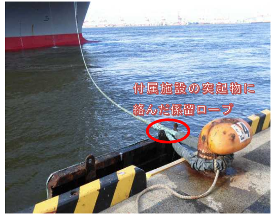
写真8：付属施設に絡んだ係留ロープ
