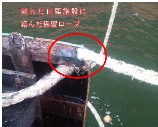
写真9：付属施設に絡んだ係留ロープ
