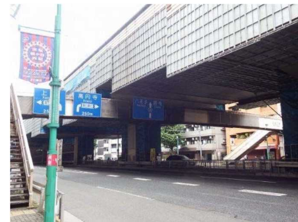
横断歩道橋（全景）
