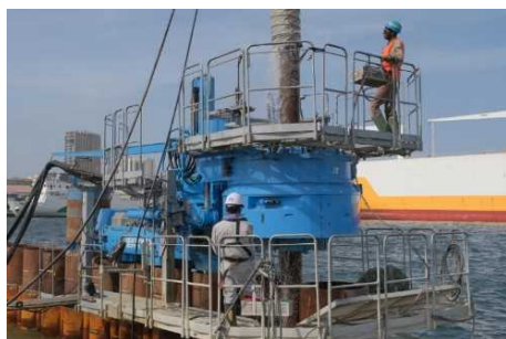
株式会社技研施工 (セネガルでの工事の様子)
