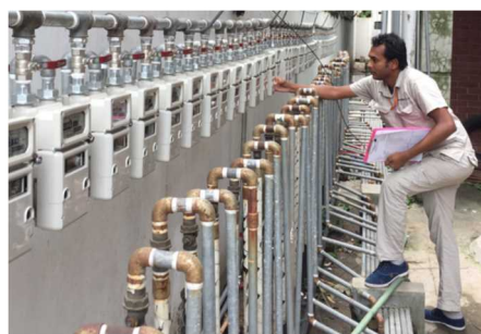
株式会社ヘリオス・ホールディングス (バングラデシュでのプリペイド式 ガスメーター設置作業)
