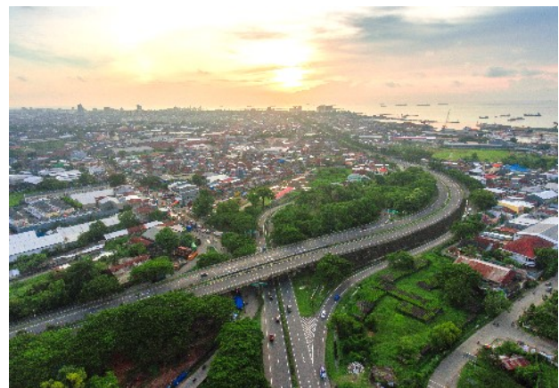
(マカッサル) タロジャンクションからスカルノ・ハッタ港を望む
