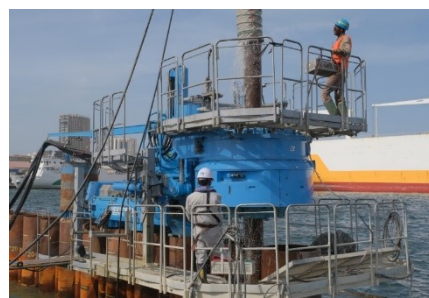
セネガルでの施工の様子
