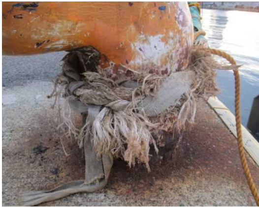
写真7：劣悪な係留ロープ
