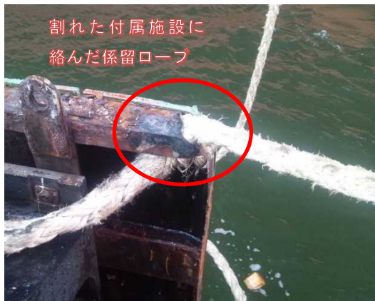
写真9：付属施設に絡んだ係留ロープ
