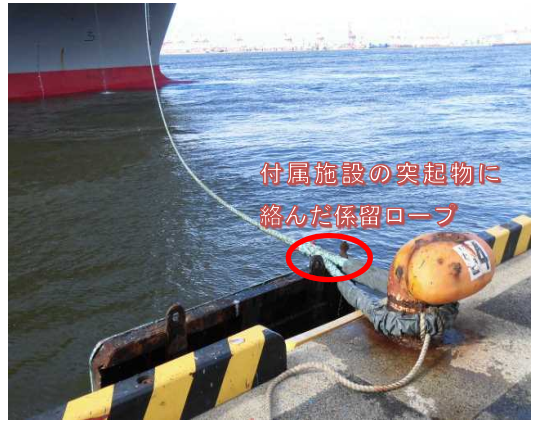
写真8：付属施設に絡んだ係留ロープ
