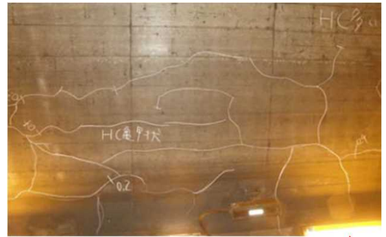
亀甲状のひび割れの例
