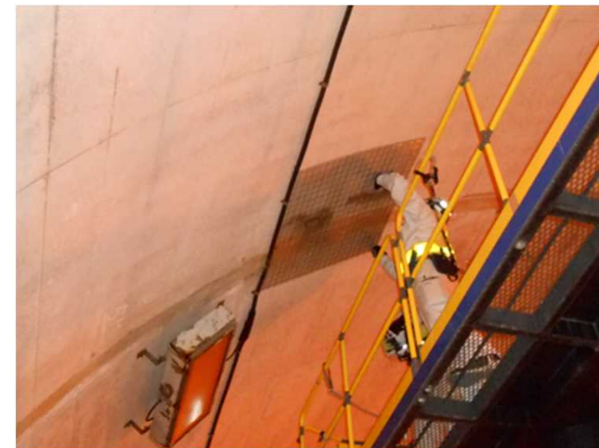
補修工事(内面補強工)の実施状況
