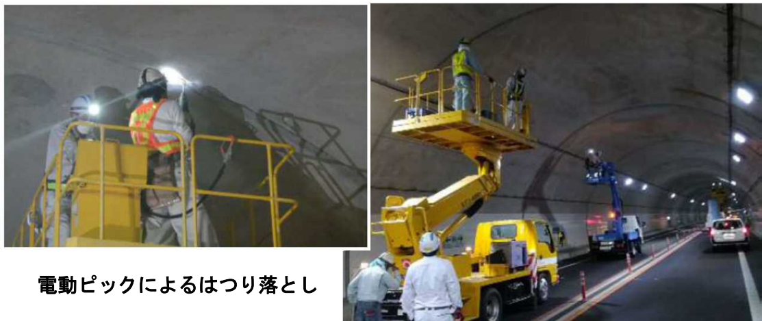
Co片のはく落発生による緊急の対策の実施状況
