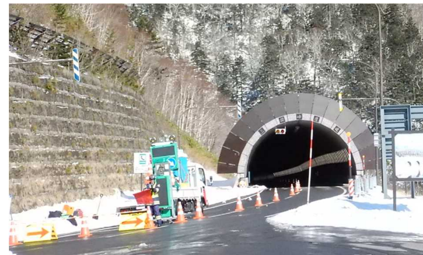
補修工事の実施状況(交通規制)
