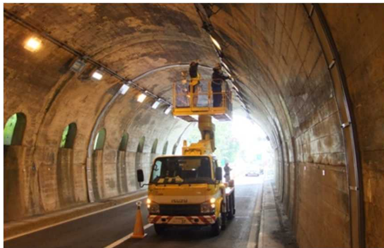
トンネル点検車による点検作業
