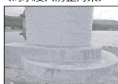
基礎部亀裂補修 (環境遮断)
