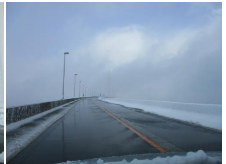
散水消雪区間
