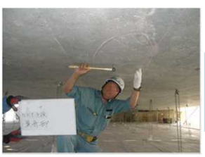
直轄定期点検
