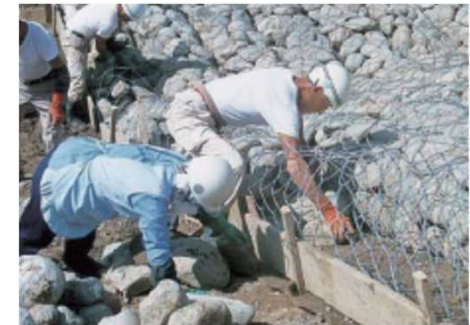
建設施工作業イメージ（かご工）
