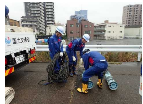
災害対応作業イメージ（排水ポンプの設置）
