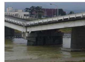
橋脚の沈下
