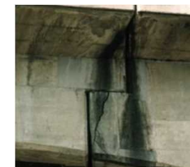
▲ゲルバー部の狭隘部
