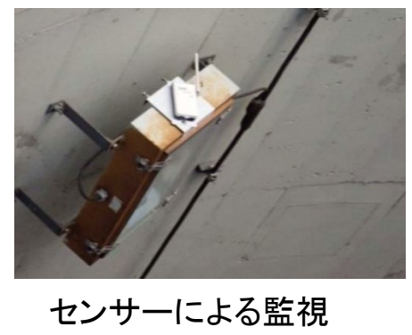
【附属物等の取付状態】
