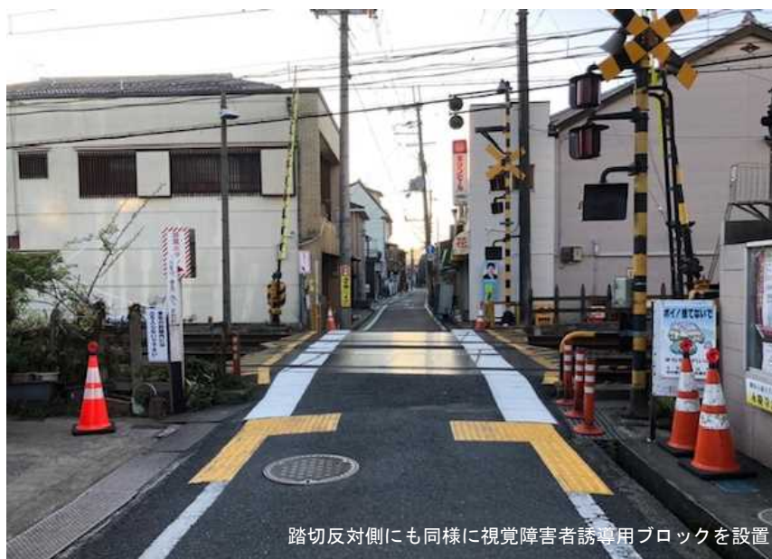
図 2-7-8 踏切道手前部に視覚障害者誘導用ブロックを設置した事例
