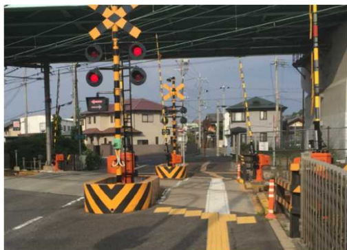
(踏切手前への視覚障害者誘導用ブロック、踏切内への誘導表示を設置した事例)
