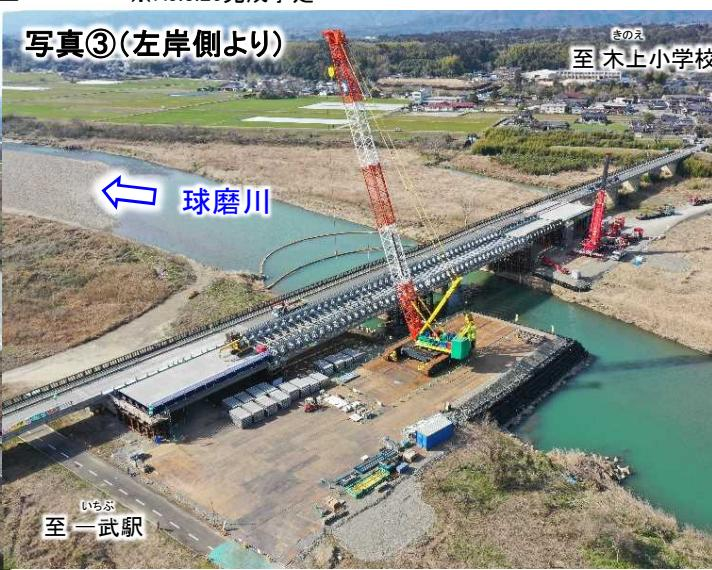
※1 ゲルバー桁：橋脚と橋脚との間にヒンジを設けた桁
