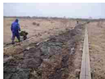
水抜き水路の埋め戻し
