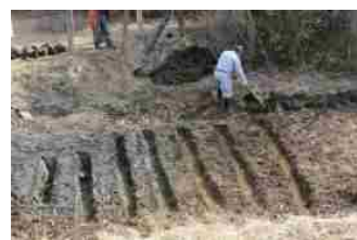
土砂堆積部分の浚渫
