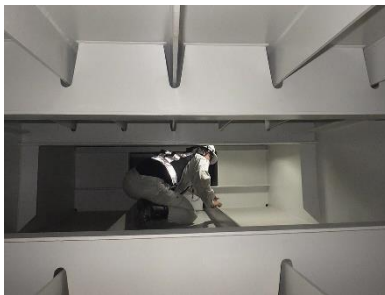
箱内空間が狭い箇所等における近接目視
