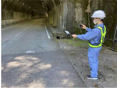
目視により路面性状を確認
