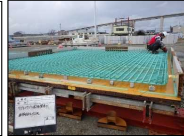
リプレイサブル床版製作状況
