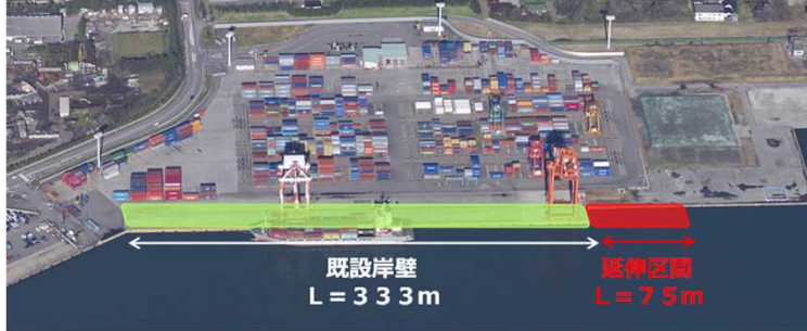
伏木富山港(新湊地区)岸壁12m
