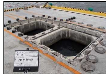
施工性確認試験実施状況(左:床版撤去、右:床版再設置(据付))
