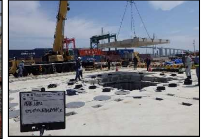
床版の設置状況
