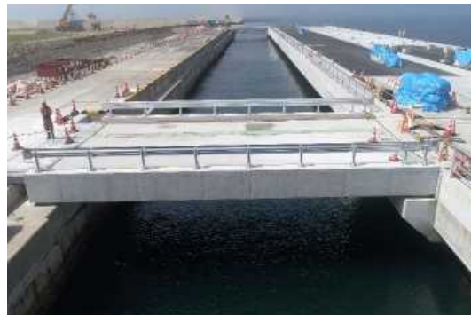
渡橋の架設状況
