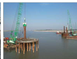
丸泰土木株式会社 バンガバンドゥ鉄道橋 (施工中)
