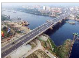
カチプール・メグナ・グムティ 新橋建設及び既存橋改修工事
