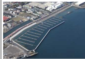
係留施設の整備
