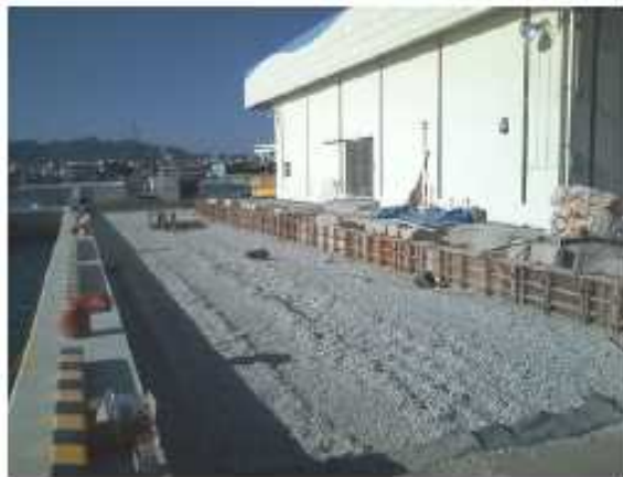
出典)「施工事例:岸壁の裏込材にL4を使用した事例」 (ガラス発泡資材事業協同組合)
