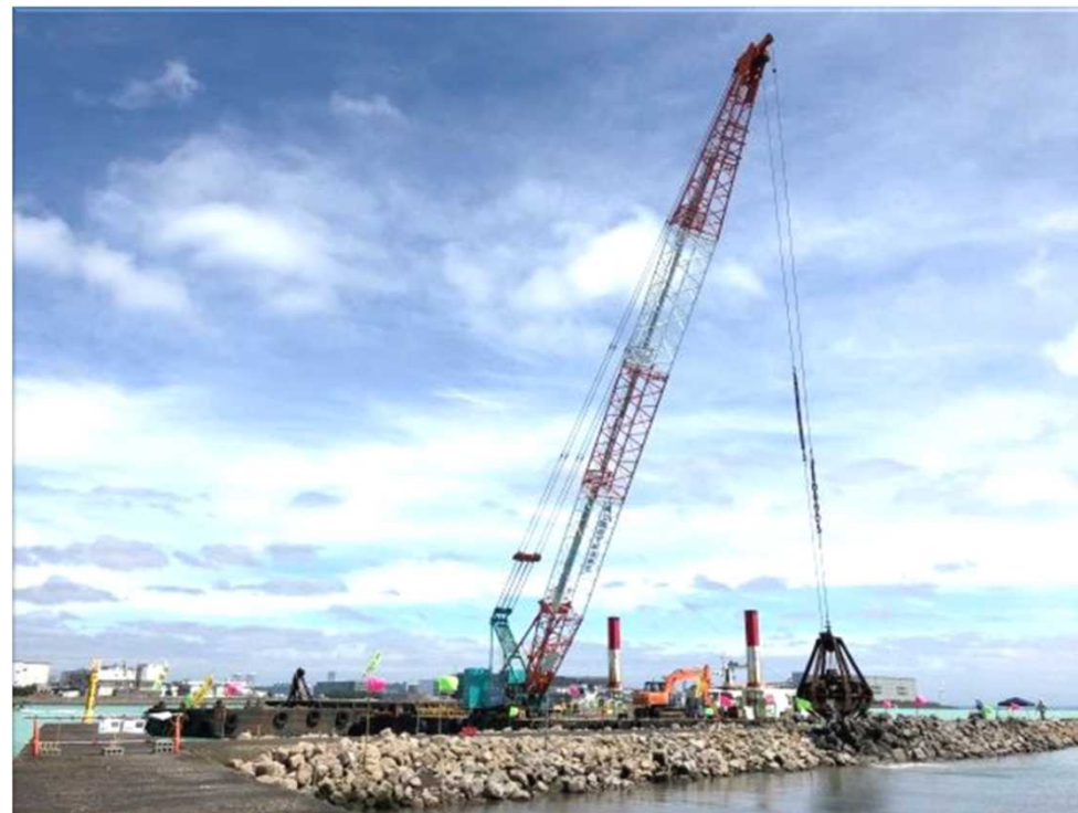
投入作業の様子
