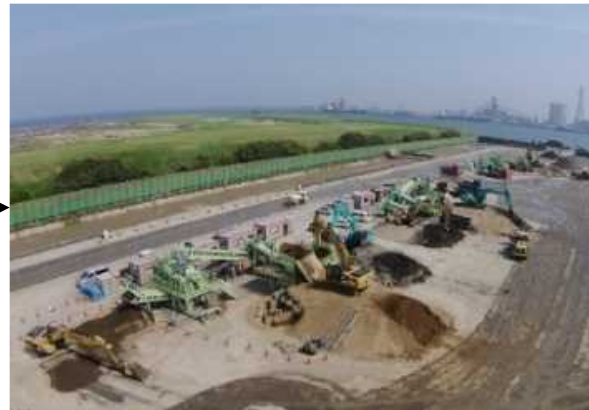
粘性土系の改質改良処理の様子
