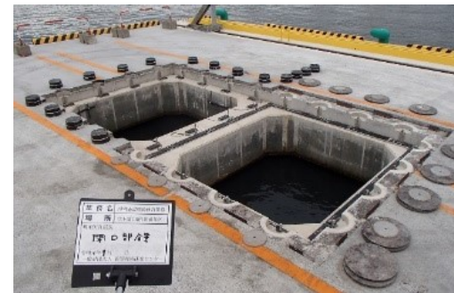
施工性確認試験実施状況(床版撤去)
