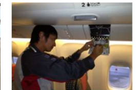
客室内の照明の交換
