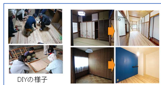
図 5-1-7 DIY を利用した空き家再生の取組
