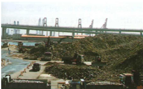
図 2.2-2 ガレキの積み出し基地（灘浜基地）
