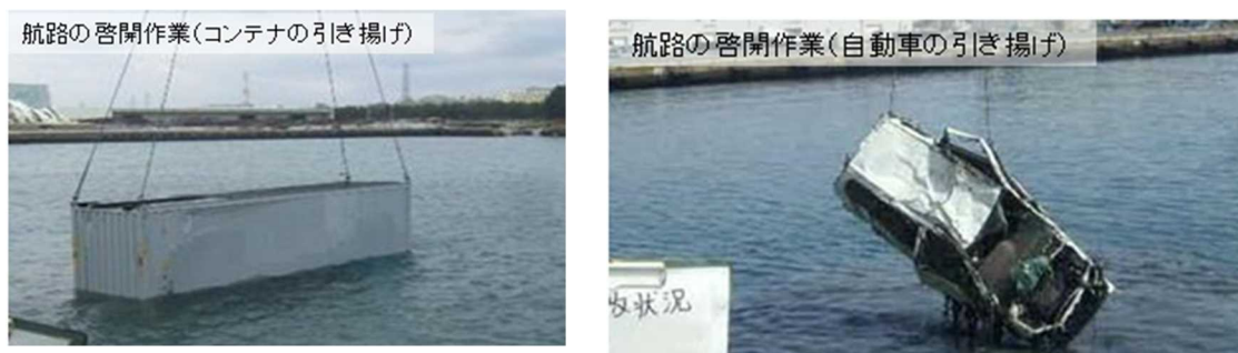
図 2.3-5 航路の啓開作業
