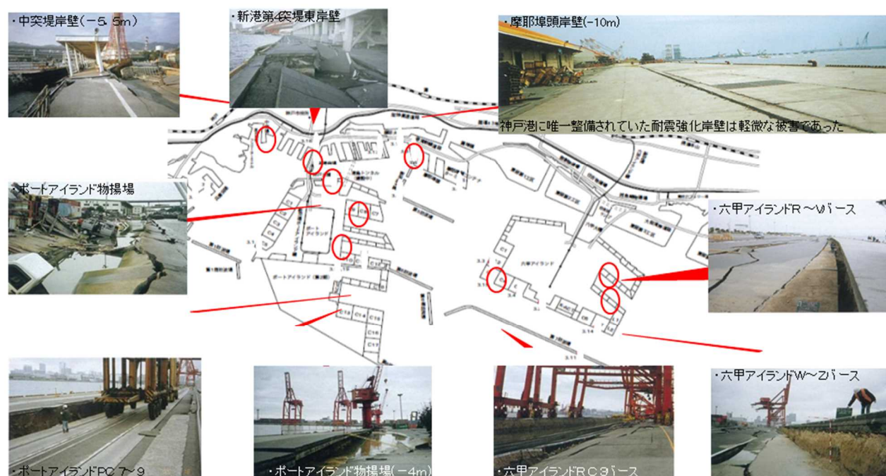
図 2.2-1 阪神・淡路大震災時における岸壁の被災状況
