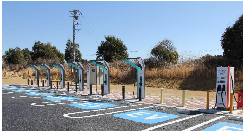
・浜松サービスエリア（下り）の150kW級急速充電器（写真右） ・6口マルチタイプ急速充電器（写真左）
