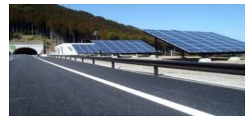
道路における太陽光発電施設活用
