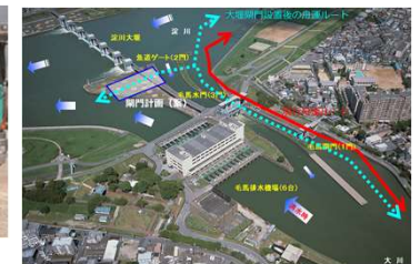
淀川大堰閘門の整備
