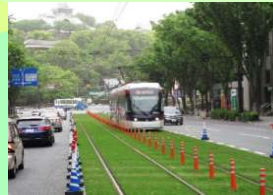
軌道敷緑化の整備 (熊本県熊本市)
