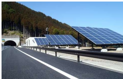
トンネル坑口付近における太陽光発電施設設置事例
