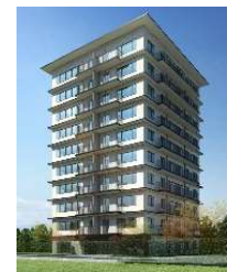
CLTを用いた10階建て共同住宅
