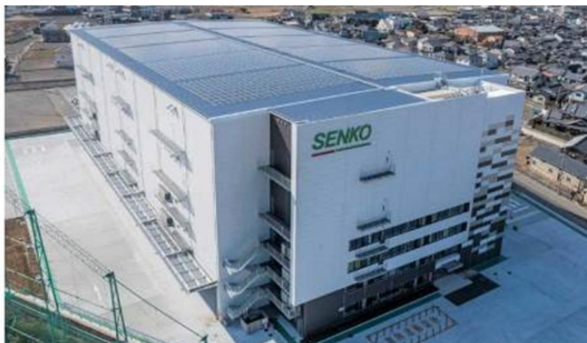
余剰電力をセンコーグループ3施設へ送電する太陽光発電
