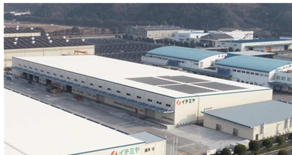
西条2号倉庫に設置された太陽光パネル
