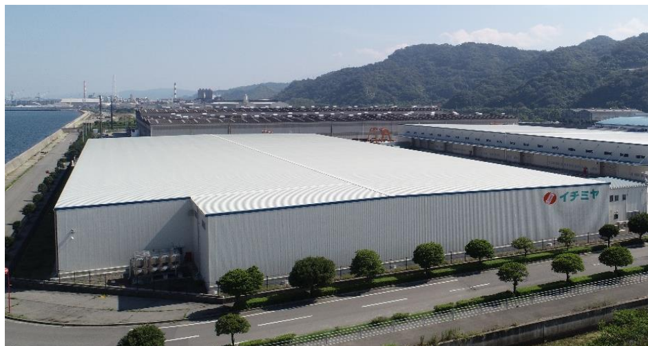
物流センター西条1号倉庫
