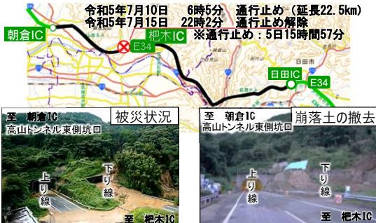
令和5年7月10日 6時5分 通行止め（延長22.5km） 令和5年7月15日 22時2分 通行止め解除 ※通行止め：5日15時57分 朝倉IC 朝倉IC E34 朝倉IC E34 朝倉IC E34 被災状況 崩落土の撤去 E34大分自動車（朝倉IC～日田IC）では道路区域外からの土砂流入により全面通行止めとなったが、4車線化していたことにより、上り線（2車線）を活用し、約5日で一般車両の通行を確保
