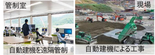
写真：成瀬ダム堤体打設工事 H P
