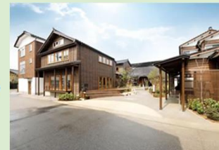
まちなかの複数の空き家と空き地を活用して、地域の拠点施設等を整備
