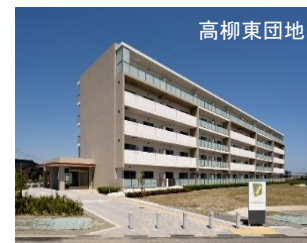
災害公営住宅整備 (宮城県名取市)
