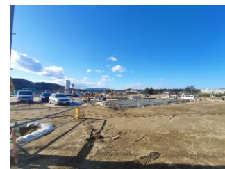
帰還者向け災害公営住宅等建設地 (双葉町 双葉駅西側地区)
