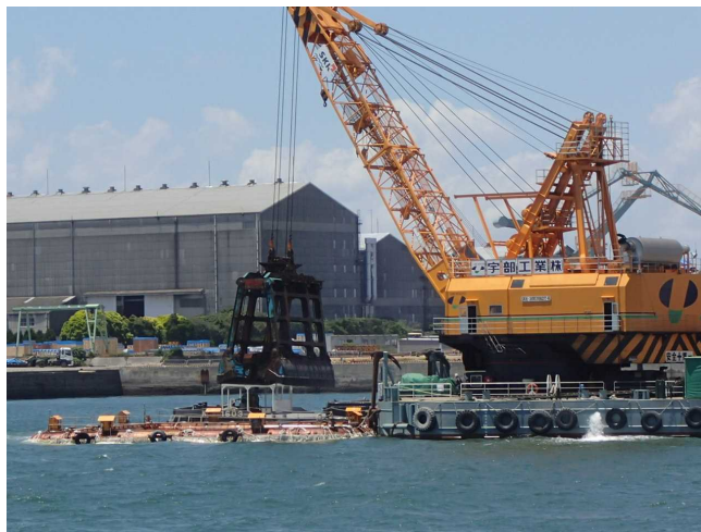
写真-3.2 グラブ浚渫船
