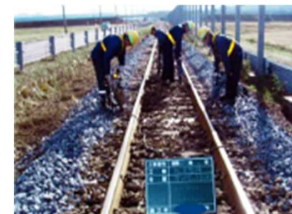
レールの修繕
