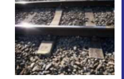
線路設備の修繕
