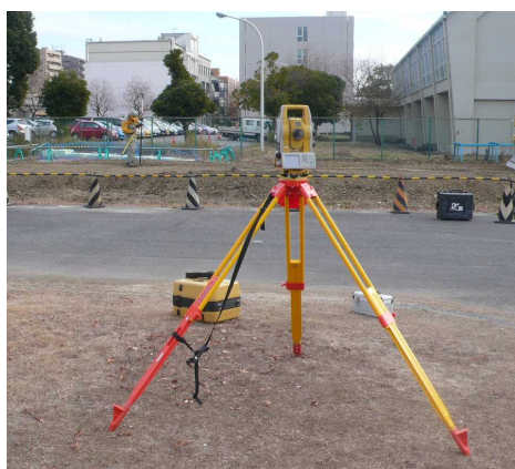
写真 - 7 TSの設置
