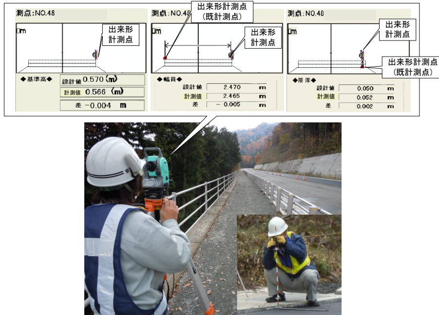
図-3 出来形計測状況
