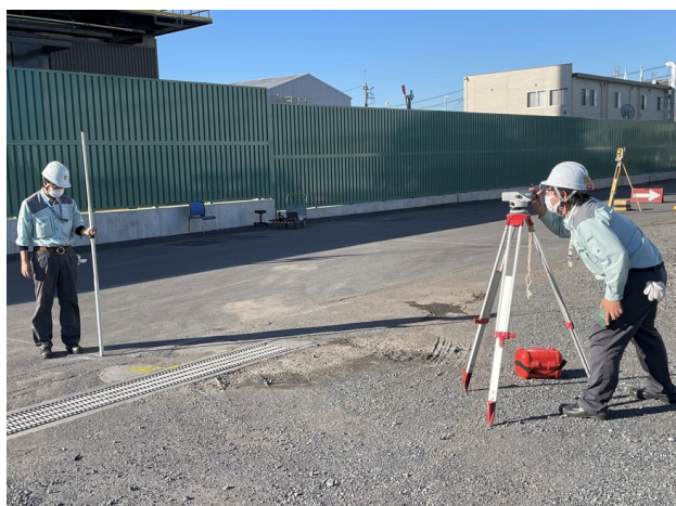
図－2 出来形計測状況
