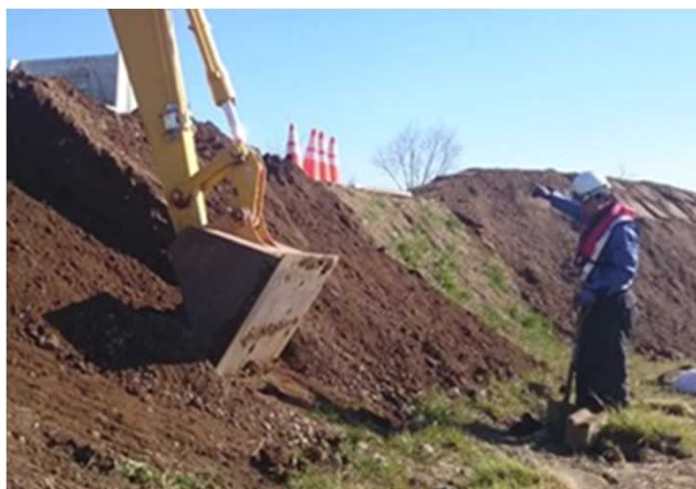
路床盛土(通常施工)
