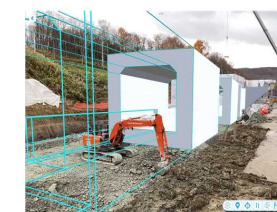
掘削作業時にARと比較
