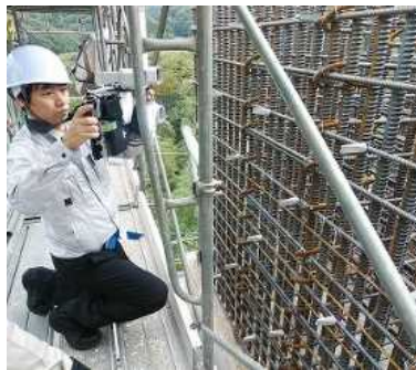
システムによる配筋検査
